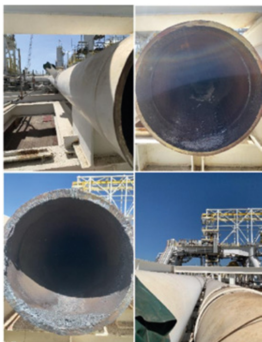
Figura 6 – Registros de inspeção visual dos sistemas de tubulação – sistema de Flare
