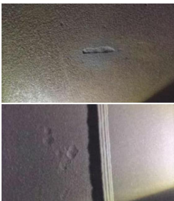
Figura 17 – Fotos da superfície interna, durante a auditoria de IVI, mostram que não há processo corrosivo, mas sim sulcos e mossas causados na fabricação e na montagem, corroborando com o C-Scan executado no INI
