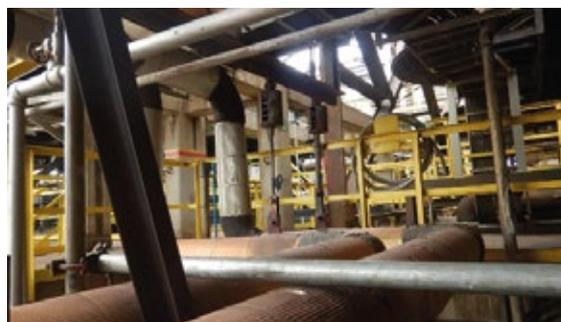
Figura 4 - Tubulações de saída do forno objeto do estudo com parte de sua suportes
