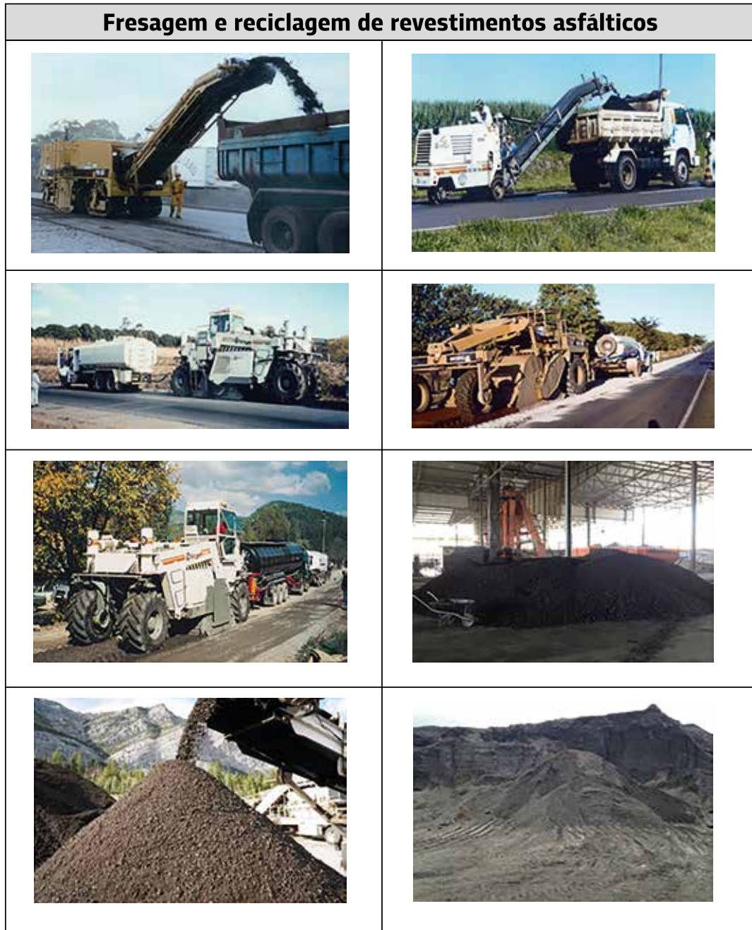
Figura 3.15 – Operação de fresagem e reciclagem de revestimentos asfálticos e exemplos de pilhas de material fresado
