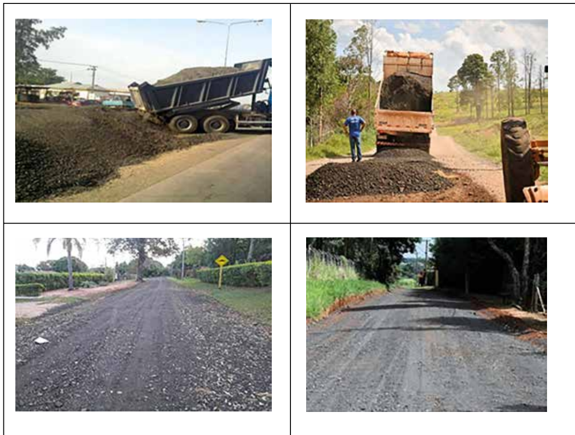
Figura 3.13 – Exemplo de utilização de material fresado em estradas rurais
