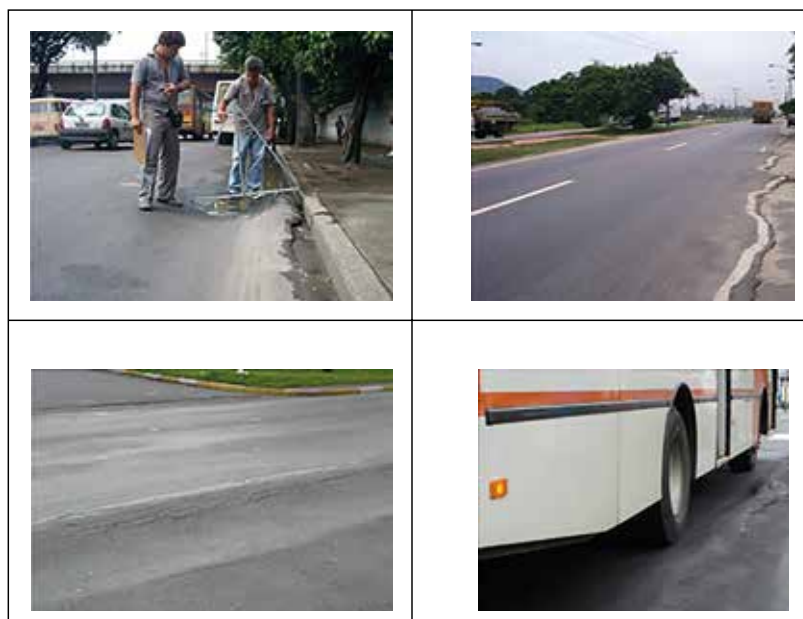
Figura 8.14 – Exemplos de defeitos de deformação permanente de concreto asfáltico devido à dosagem inadequada
