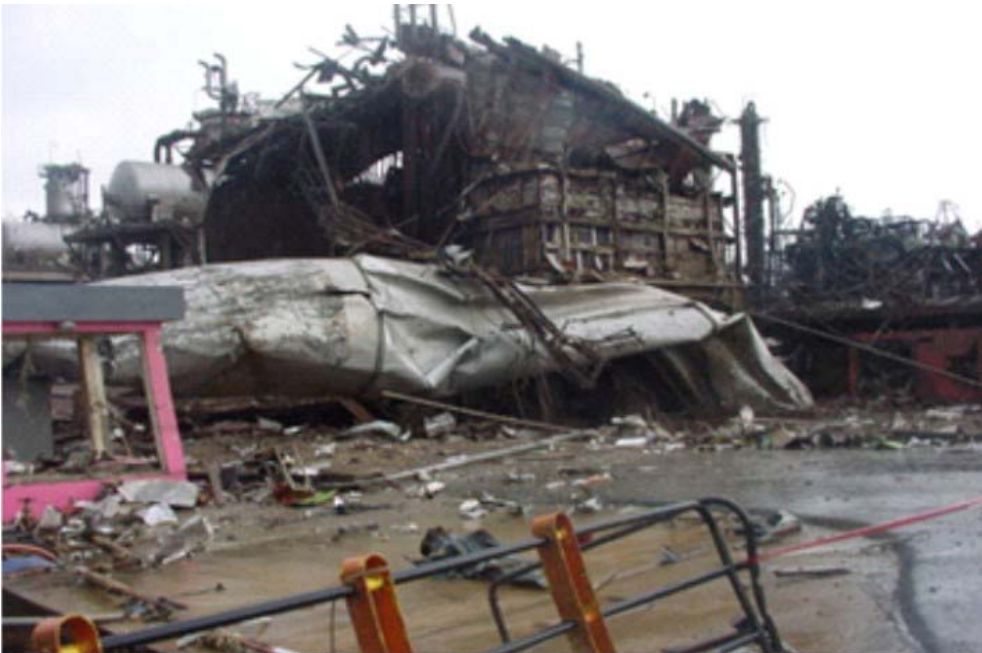
Figura 26 - Exemplo de explosão de caldeira pelo lado vapor.
