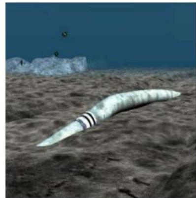
Figura 4b: Duto enterrado com trecho exposto. | Fonte: Prado (2015).
