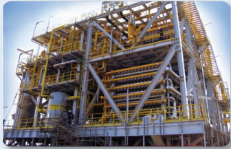
Primeira separação de CO2 associado ao gás natural em águas ultra-profundas com reinjeção de CO2
