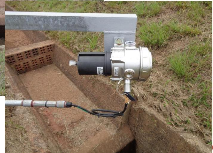
Vista geral dos detectores de gás instalados junto as canaletas dos diques.
