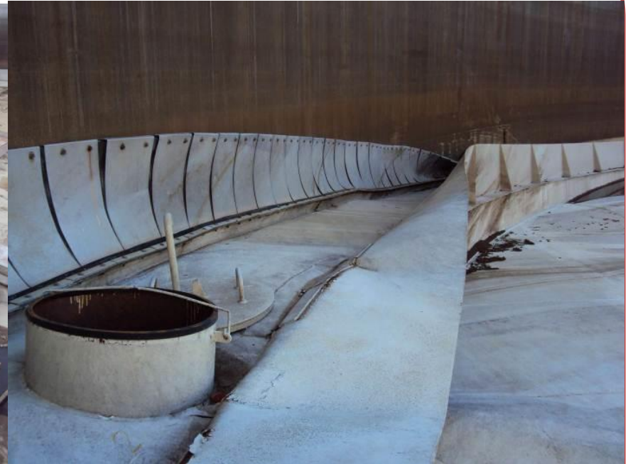
Dobramento da chapa do dique do anel flutuador
