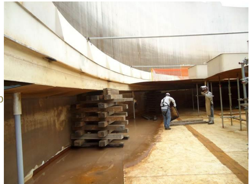
Remoção das Chapas do Teto
