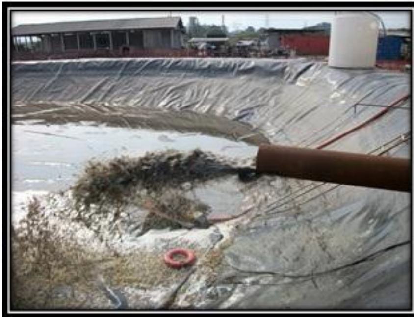
EFLUENTE SEM TRATAMENTO
