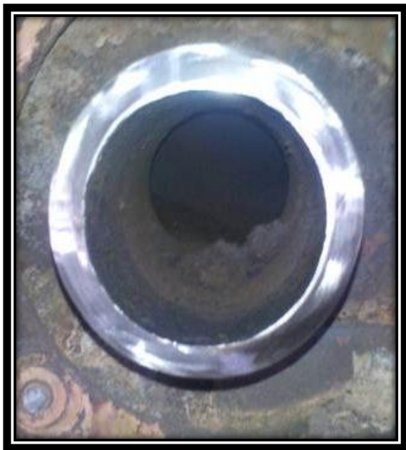
Antes da Limpeza Química
