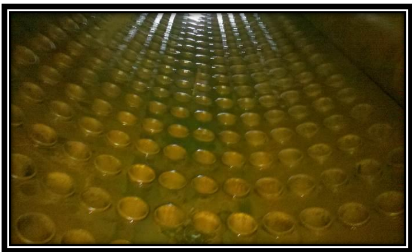
Antes da Limpeza Química
