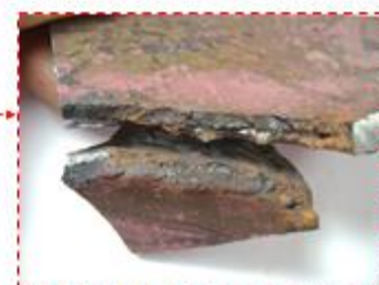
Detalhe da fratura.
